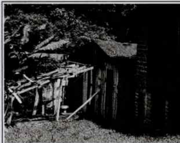
Casa 4 – parcialmente demolida
