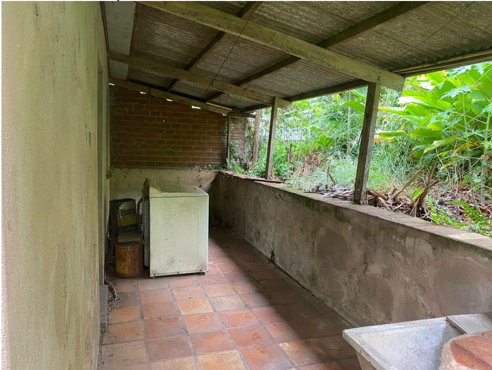
6 – Fundos da construção
