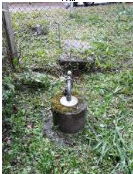
Figura IV-56: Poço Captação Bairro Picada 48 Alta
