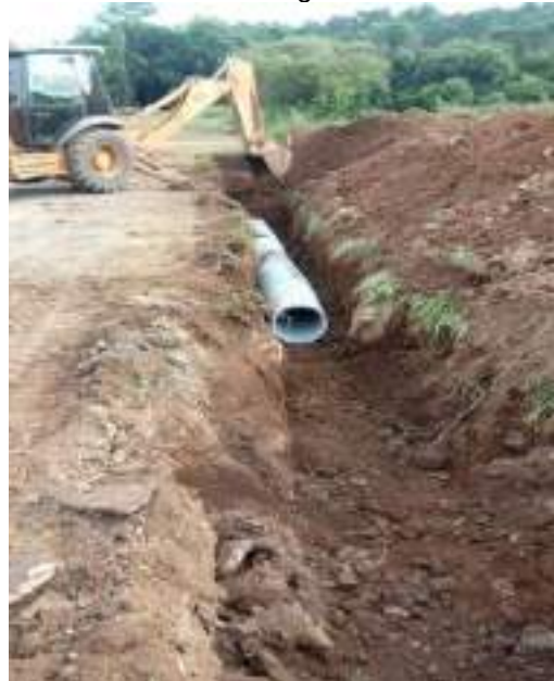
Figura IV-88: Melhoria no Sistema de Drenagem
