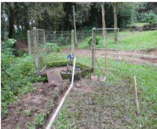
Figura 4-21: Interligação do poço 90 com a rede da Av. Capivara.
