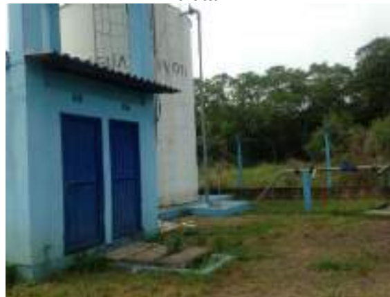
Figura IV-34: Manancial de captação de água bruta
