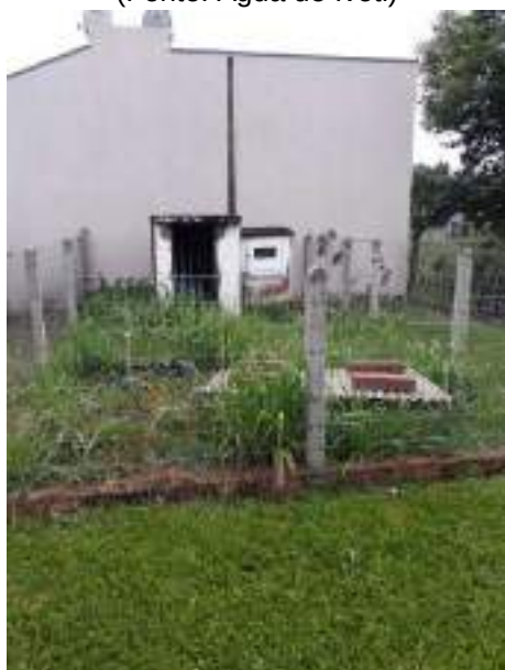
Figura 4-30: Poço Captação Bairro Nova Vila (Fonte: Água de Ivoti)
