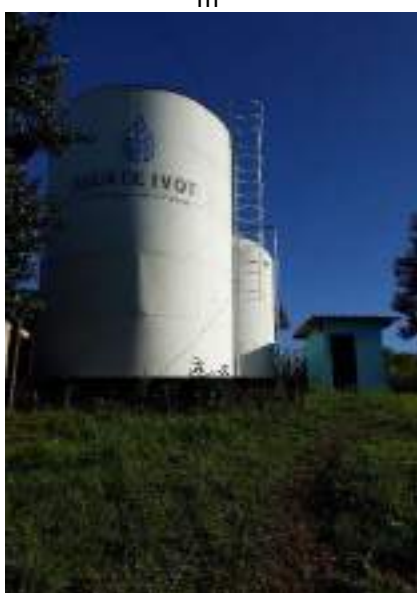
Figura IV-45: Reservatório água tratada 215 m 3
