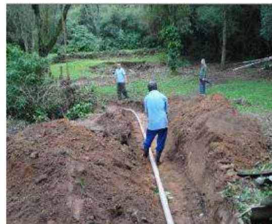
Figura 4-21: Interligação do poço 90 com a rede da Av. Capivara.
