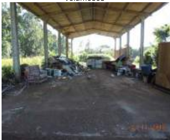
Figura IV-78: Local provisório de acondicionamento dos resíduos sólidos volumosos
