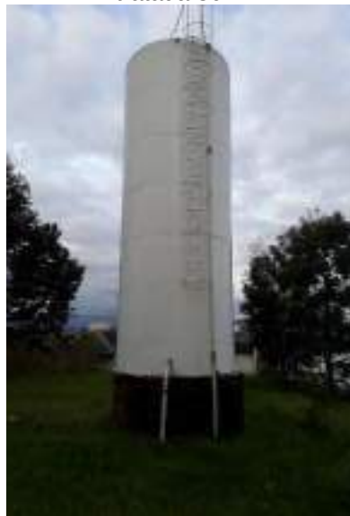
Figura IV-48: Reservatório água tratada 30m 3
