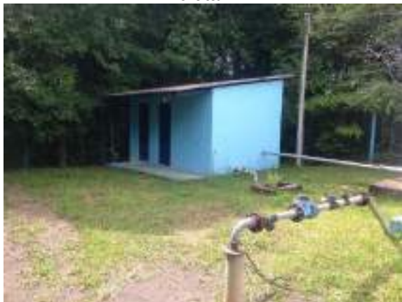
Figura IV-33: Manancial de captação de água bruta
