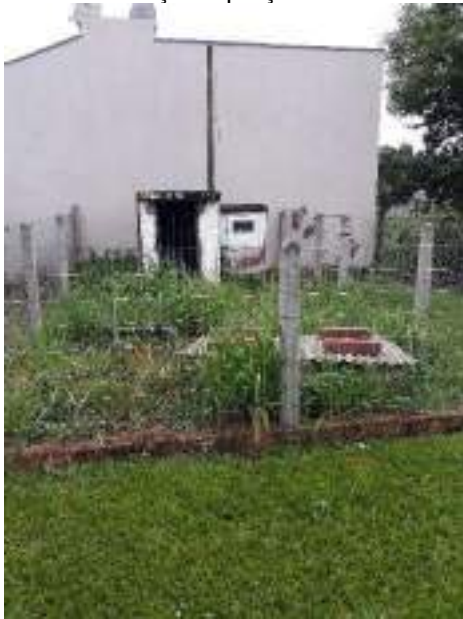
Figura IV-59: Poço Captação Bairro Nova Vila
