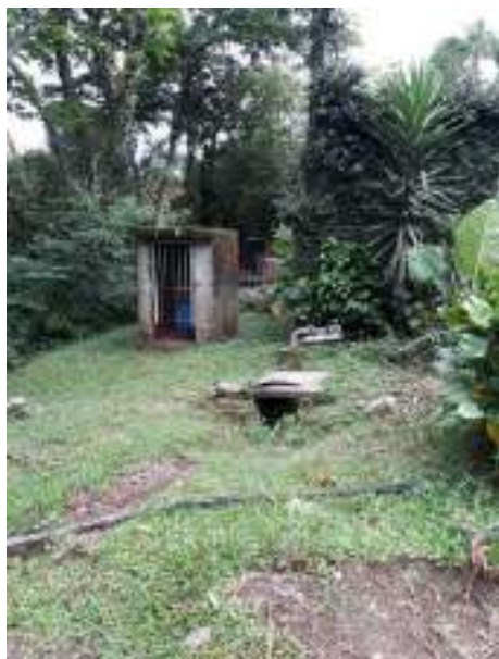
Figura 4-24: Poço Captação Bairro União (Fonte: Água de Ivoti)
