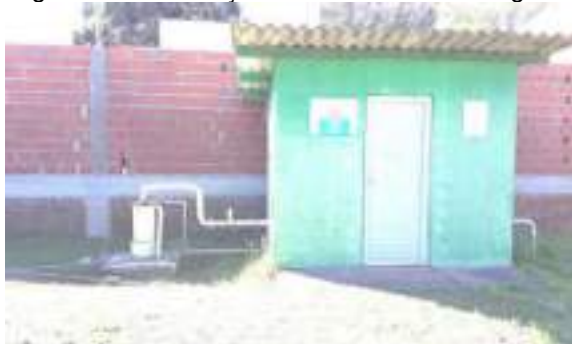
Figura IV-39: Estação de Tratamento de Água
