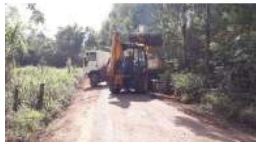
Figura 7-5: Drenagem Pluvial nas áreas rurais (Fonte: Prefeitura Municipal de Ivoti)
