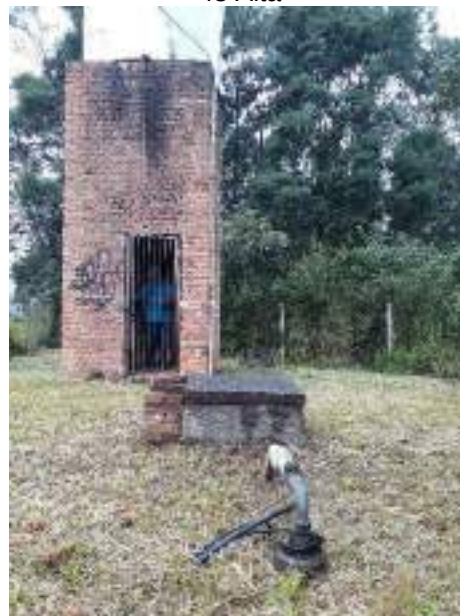
Figura IV-58: Poço Captação Bairro Picada 48 Alta
