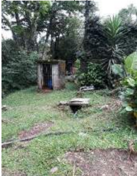
Figura IV-53: Poço Captação Bairro União
