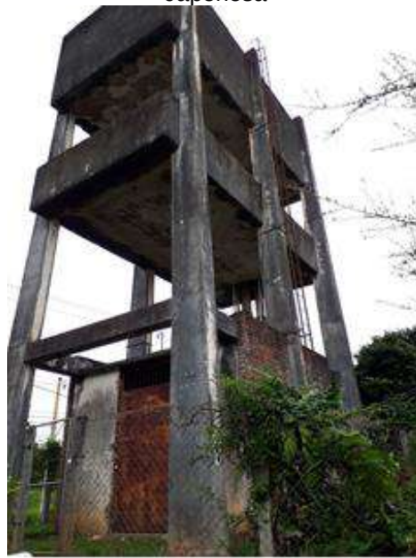
Figura IV-52: Reservatório Colônia Japonesa
