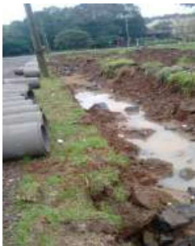
Figura 7-2: Melhorias no Sistema de Drenagem na rua Anselmo Seth (Fonte: Prefeitura Municipal de Ivoti)
