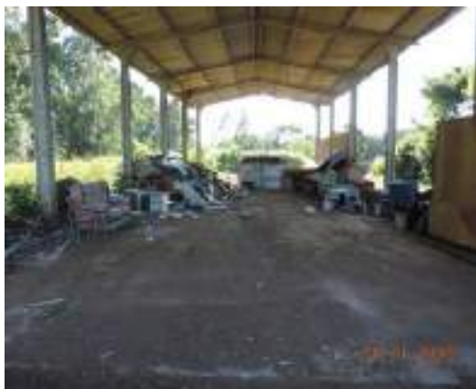
Figura 6-14: Local provisório de acondicionamento dos resíduos sólidos volumosos (Fonte: Prefeitura Municipal de Ivoti)
