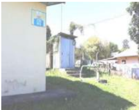
Figura 4-6: Ponto de captação (Fonte: Água de Ivoti)
