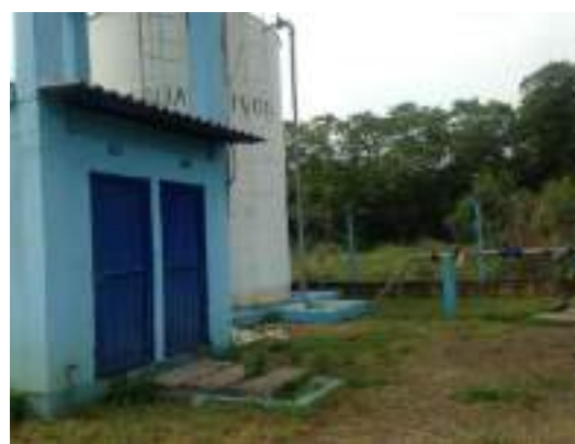
Figura 4-5: Manancial de captação de água bruta (Fonte: Água de Ivoti)
