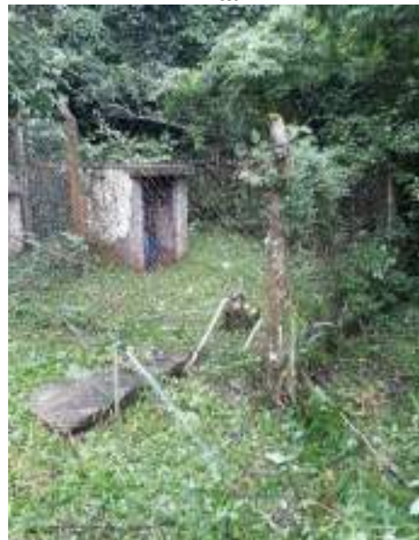
Figura IV-54: Poço Captação Bairro Picada 48 Alta
