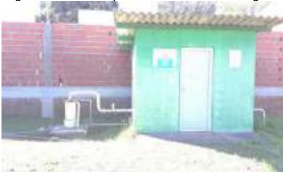
Figura IV-39: Estação de Tratamento de Água
