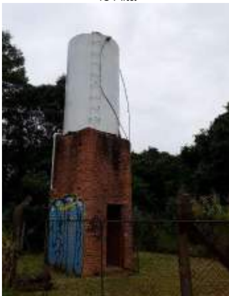
Figura IV-57: Poço Captação Bairro Picada 48 Alta
