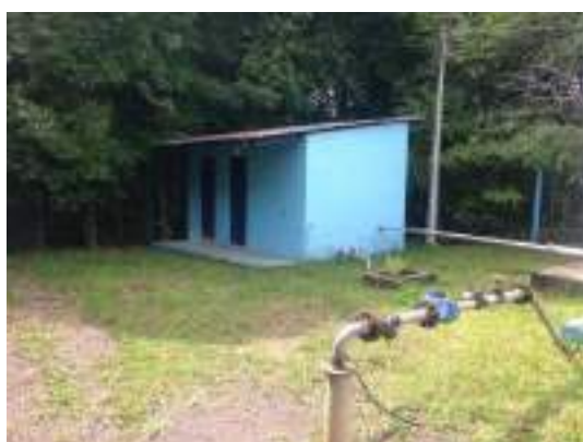
Figura 4-4: Manancial de captação de água bruta (Fonte: Água de Ivoti)
