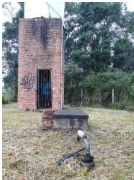
Figura 4-29: Poço Captação Bairro Picada 48 Alta (Fonte: Água de Ivoti)
