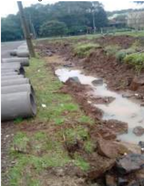
Figura IV-87: Melhoria no Sistema de Drenagem na rua Anselmo Seth
