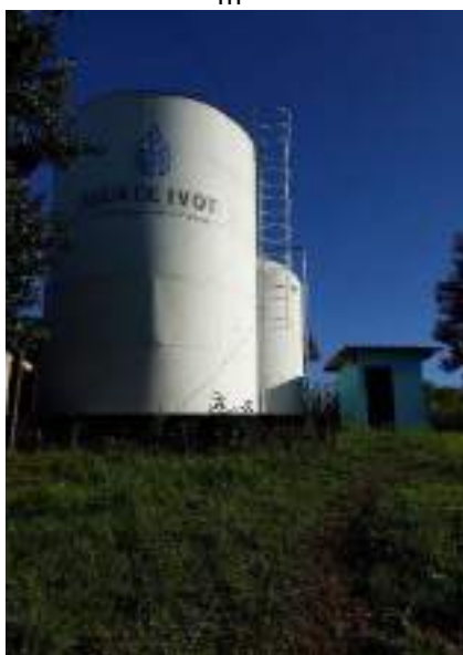
Figura IV-45: Reservatório água tratada 215 m 3
