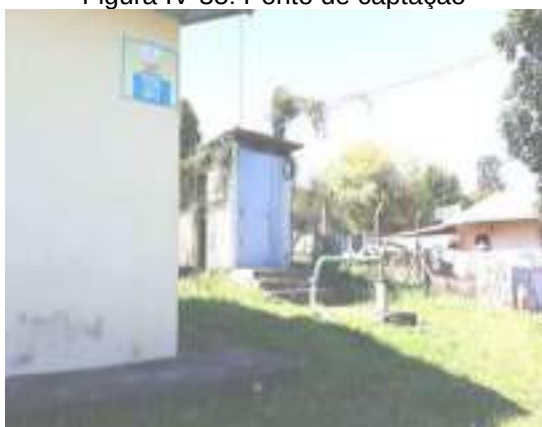
Figura IV-35: Ponto de captação
